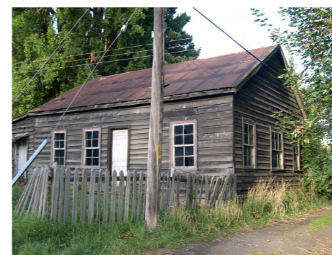
Vista fachada principal Casa de Trabajadores
