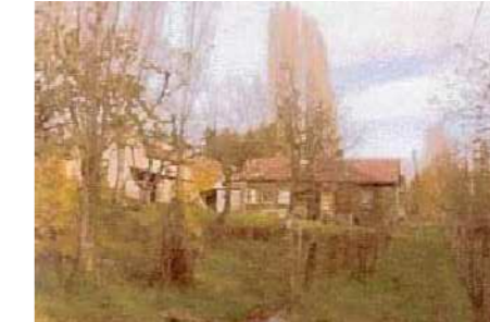
Vista acceso principal Casa de Administrador
