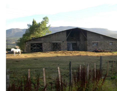
Vista acceso Cocina de Peones
